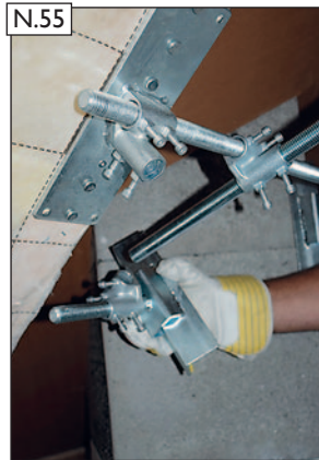
Gewindestange in Spann-kreuze des oberen und unteren Schornsteinhalters einfädeln und dabei das Spannkreuz mit dem 45° Spannwinkel mit auffädeln.
