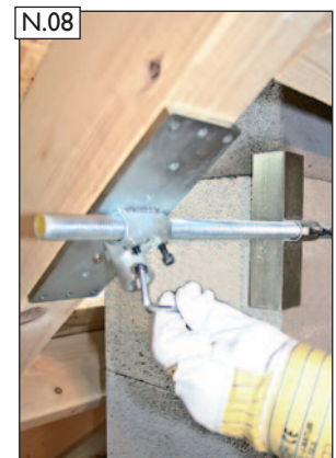
N.08 Gewindestange fixieren. Dazu die Abreißschrauben an beiden Sparrenhaltern mit Inbusschlüssel (E) anziehen bis der Schraubkopf an der Sollbruchstelle abreißt.
