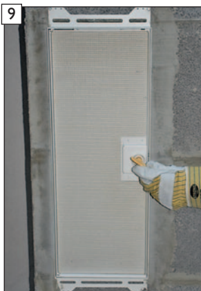
BlowerDoor Kondensat- blendentürblatt abnehmen.
