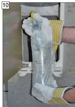
Kondensatauffangbeutel vorsichtig herausziehen.
