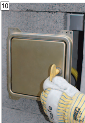
Kondensatblendentürblatt wieder verschließen.
