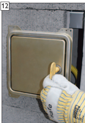
BlowerDoor Kondensatblendentürblatt abnehmen.
