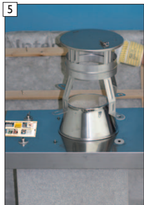
Silikondichtungen auf Zuluftkopfplatte-Edelstahl auflegen. Regenhaube „EAGLE“ aufsetzen.
