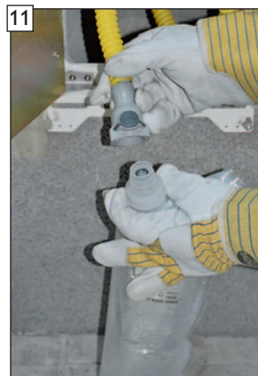
Durch Druck auf den Knopf der Kupplung kann der Kondensatauffangbeutel tropfsicher entkoppelt werden.
