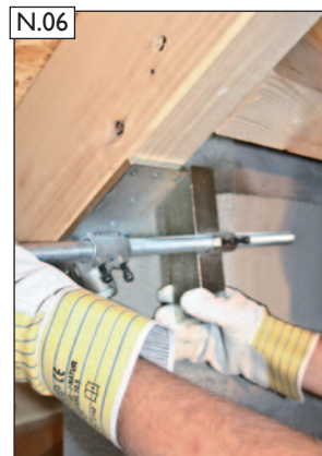
N.06 Gewindestange und Spann-winkel wieder einfädeln.
