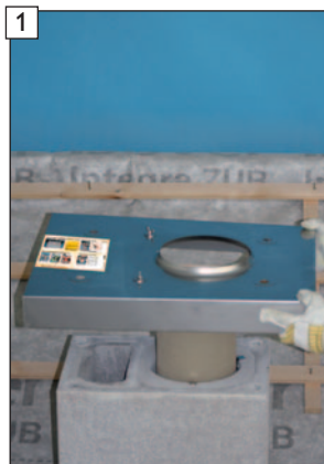
1 Zuluftkopfplatte-Edelstahl auflegen.
