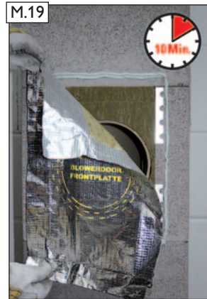
Spezial-Alugewebefolie innerhalb von 10 Minuten ausgerichtet ansetzen und ...
