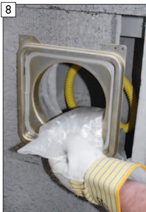
Siphonschlauch und Kondensatauffangbeutel in Schornsteinfuß einschieben.
