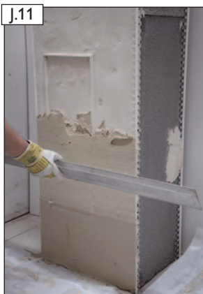
J.11 Bauseitigen Oberputz auftragen.
