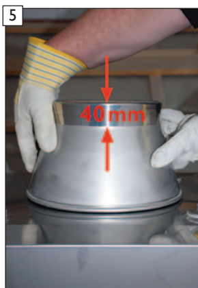
5 Konus bis ca. 2-3 mm auf Zuluftkopfplatte aufschieben.
