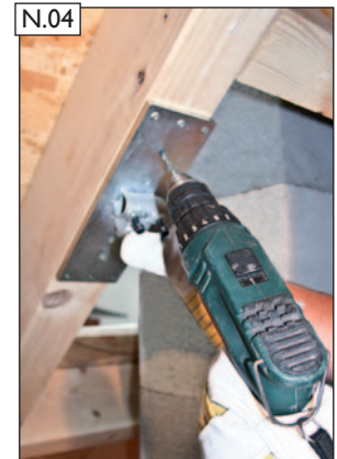
N.04 Sparrenhalter anhalten und Nagellöcher gemäß dem Nagelbild (siehe oben) vorbohren.
