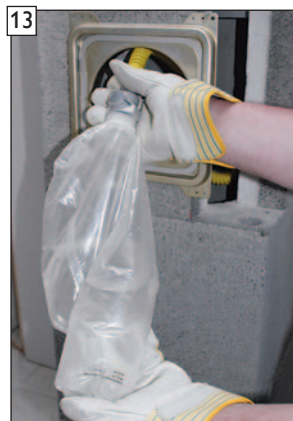
Kondensatauffangbeutel vorsichtig herausziehen.
