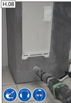
Bauseitige Öffnungsbohrung herstellen.
