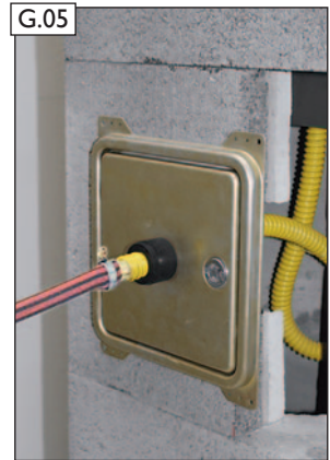
Beispiel: bauseitige Ableitung mittels Schlauch 3/4".
