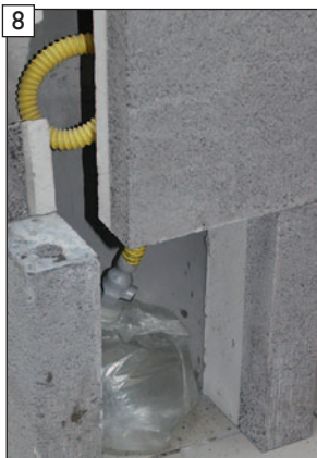
Fertigansicht am Beispiel: Ausführung mit ange- schlossenem Kondensat- auffangbeutel.
