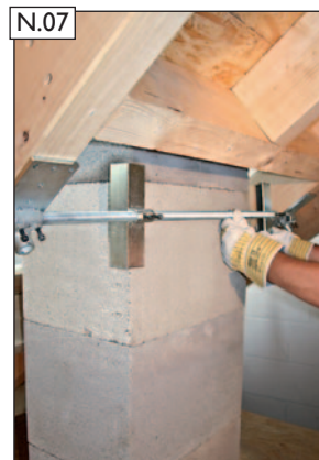
N.07 Spannwinkel an beiden Seiten ausrichten.
