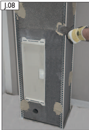
J.08 Anbringen der bauseitigen Putzschienen.
