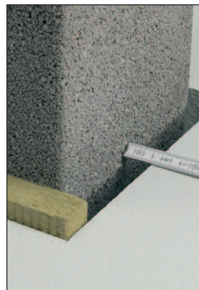
Montageausparung allseitig 3 cm größer als Mantelsteinmaß.
