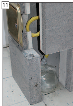
Fertigansicht am Beispiel: Ausführung mit geschlossenem Kondensatblendentürblatt und angeschlossenem Kondensatauffangbeutel.
