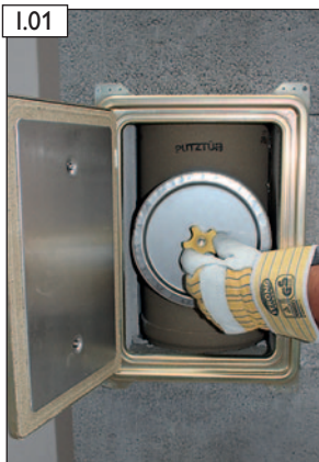
I.01 Standardrevisionsverschluss einsetzen.
