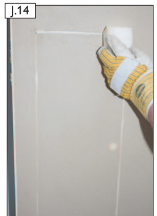
J.14 Schutzdichtung mit Schwamm nacharbeiten.
