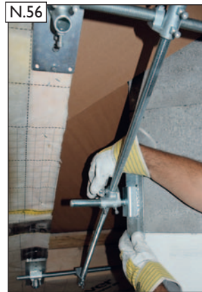
Spannwinkel ausrichten und vorfixieren.
