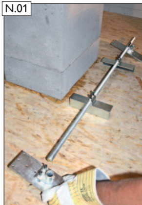
N.01 Ersten Schornsteinhalter vorbereiten. Spannhalter und Sparrenhalter lose auf die Gewindestange auf-fädeln.
