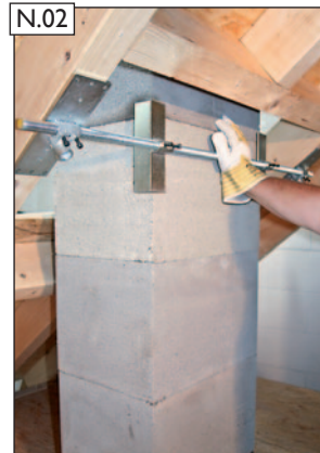
N.02 Aufgefädelt Einzelteile zum einrichten anhalten.
