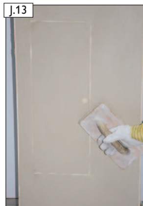
J.13 ... dabei die Schutzdichtung bündig freireiben.
