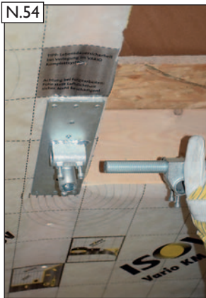
Gewindestange und 45° Spannwinkel wieder ein-fädeln und ausrichten.
