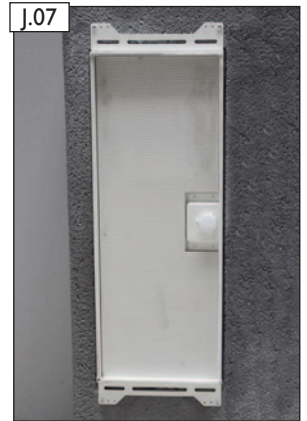
J.07 Fertigansicht mit vollständig eingebrachter Schutzdichtung.
