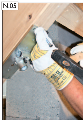
N.05 Sparrenhalter mit Kamm-nägeln (D) ausnageln.
