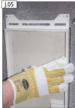
J.05 Schutzdichtung weiter einbringen und auf „planen“ Sitz achten.
