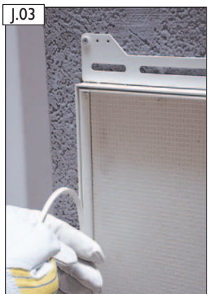
J.03 Schutzdichtung in den Türspalt der BlowerDoor Design-Putztür einbringen und an der Ecke abschneiden.
