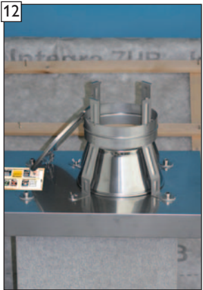
Der Revisionsdeckel ist mit einer Drahtschlinge, als „Absturzicherung“, verbunden. Die Drahtschlaufensicherung mind. einmal im Jahr überprüfen und ggf. erneuern.
